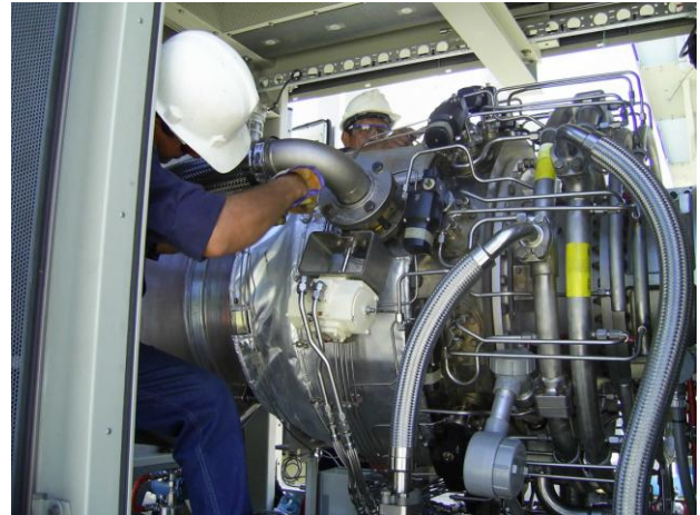
Mantenimiento de turbina
